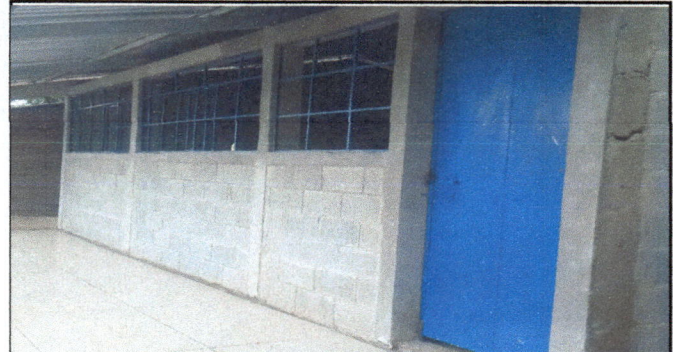
Foto 2: Las paredes de blocks remozadas de este aula.
