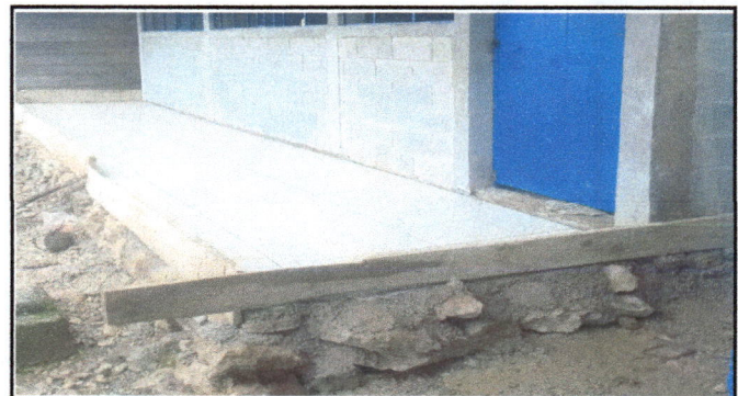
Foto 4: Concreto fundido para el corredorcon piso ceramico instalado.
