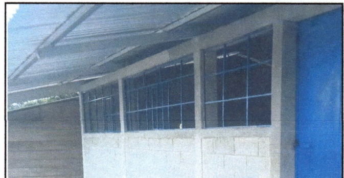
Foto 6: Ventanas de metal con vidrios instaladas en este aula o módulo.
