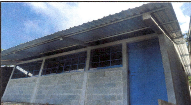
Foto 3: Sustitucion decubierta de laminas para el techo con laminas troqueladas.
