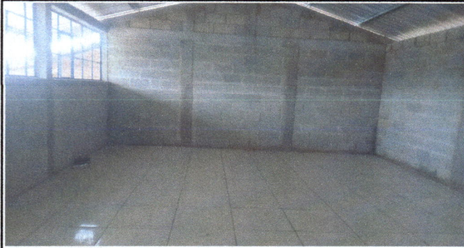
Foto1: Piso del aula con nuevo mortero y piso cerámico colocado.
